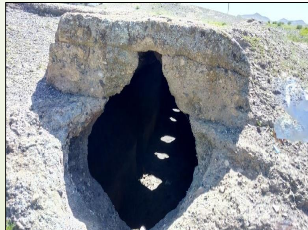
Orifices cylindriques au sommet des voûtes
